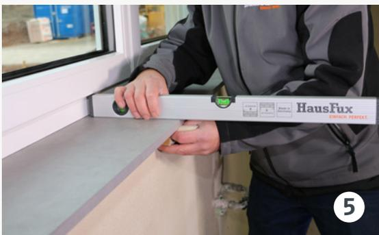
5 Fensterbank mit Hilfe von Richtwerkzeug ausrichten.
