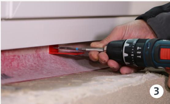
3 Montagekelle abziehen und Kunststoffwinkel anschrauben.
