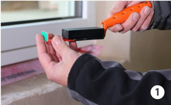
1 Selbstklebenden Kunststoffwinkel auf Montagekelle schieben und Schutzfolie abziehen.
